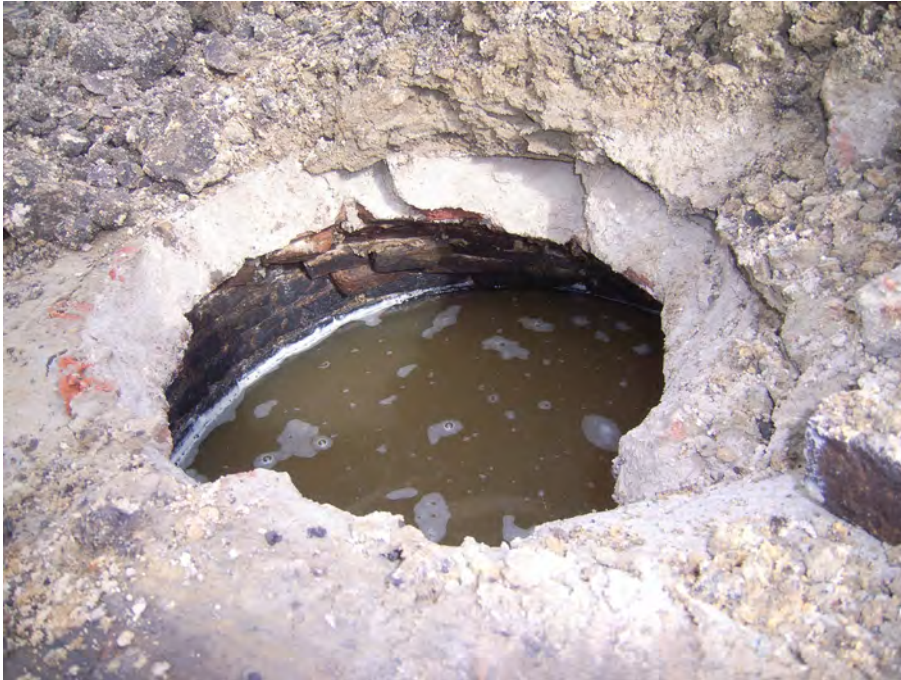
Afb. 4.34 Detailfoto van de binnenzijde van de stenen koepel van één van de waterputten (spoor 3109).
