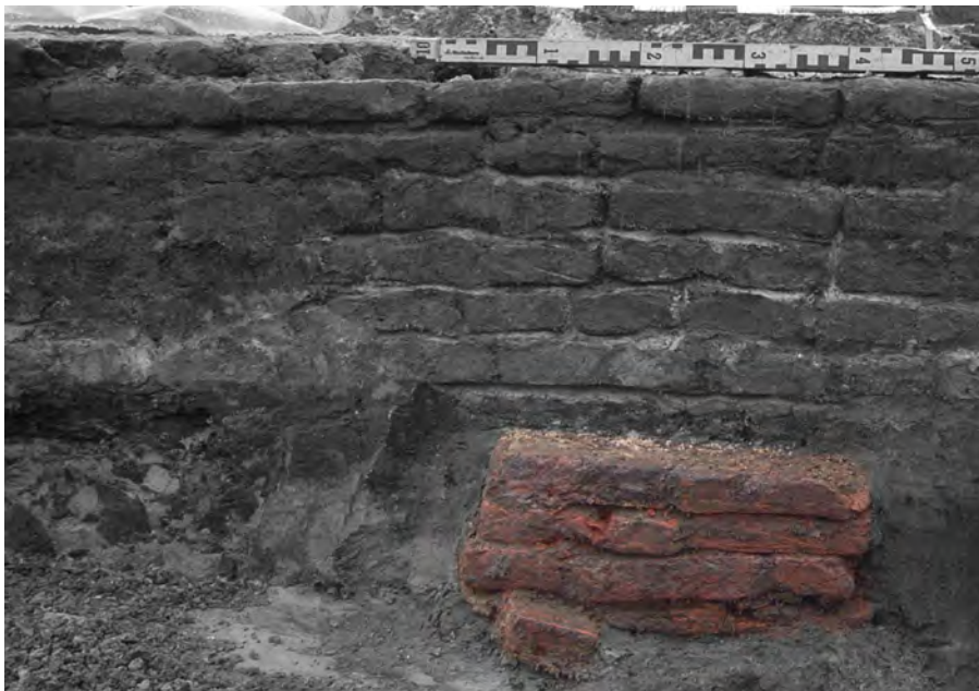
Afb. 4.15 Foto van de noordelijke poer die bewaard is gebleven onder de binnenmuur van de noordelijke zijbeuk (gezien naar het zuiden).
